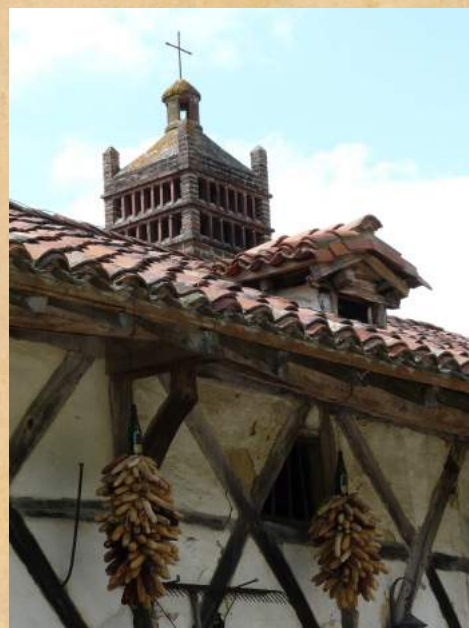
La souche ouvragée de la cheminée sarrasine ou « mitre » évacue la fumée du foyer « chauffant au large » Archives départementales de l'Ain
