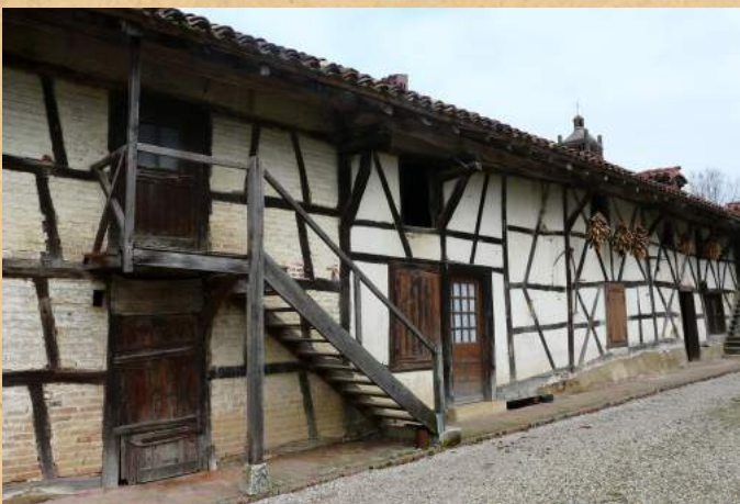
La façade de ferme en pans de bois remplis de torchis pour la partie ancienne et de briques pour son extension Archives départementales de l'Ain
